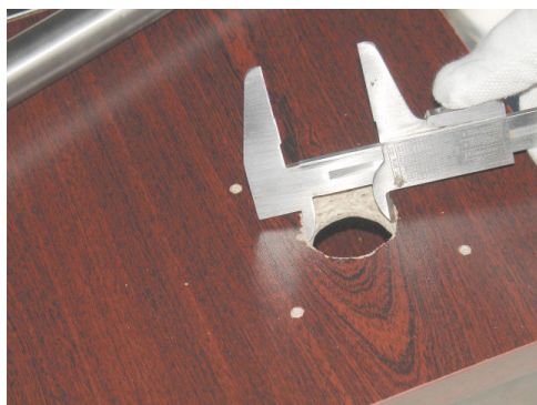
a) Wykonane otwory pod montaż miernika
